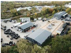
Aktuelles/25. Oktober 2019; Vorbereitung des Baus einer neuen Halle.
